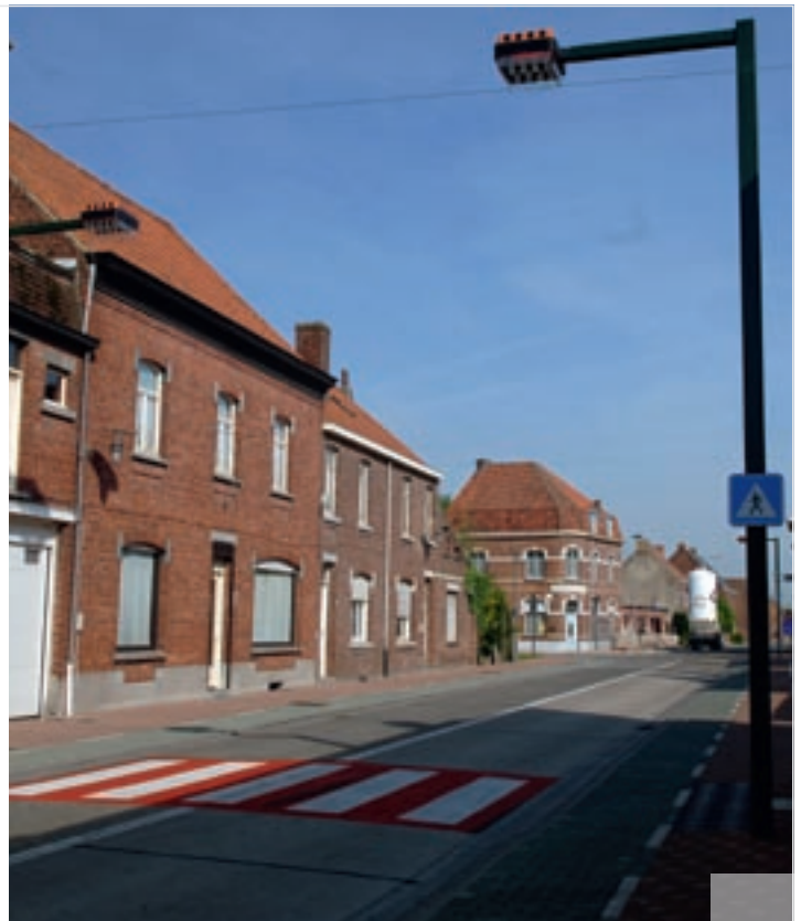
Comines : aménagement de voirie. Source : SPW – Direction de l'édition.
